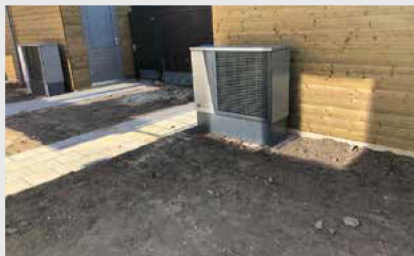
Buitenunit lucht/water-warmtepomp"
