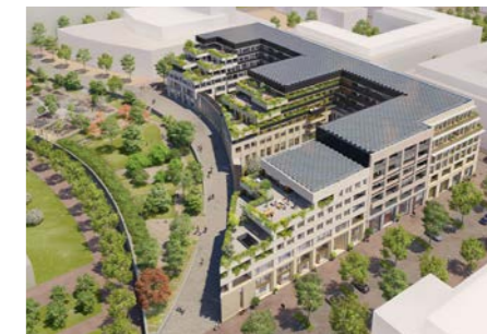
Twee binnentuinen verbinden het gebouw visueel met het omliggende landschap. Ze vormen ook een natuurlijke waterbuffer en weren hitte.
