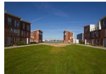
Het groene wadi-systeem zorgt voor de natuurlijke opvang en afgifte van regenwater.
