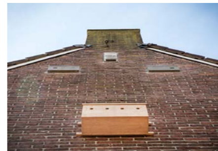
Aan de gevels werden tijdelijke 'mussenhotels' aangebracht.
