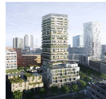
De daktuinen hebben een integratiesysteem voor regenwater. Het houdt regenwater op de verdieping vast om verdroging tegen te gaan. Bij de nadering van regenbuien loopt de waterbuffer leeg. Dit systeem is volledig geautomatiseerd.
