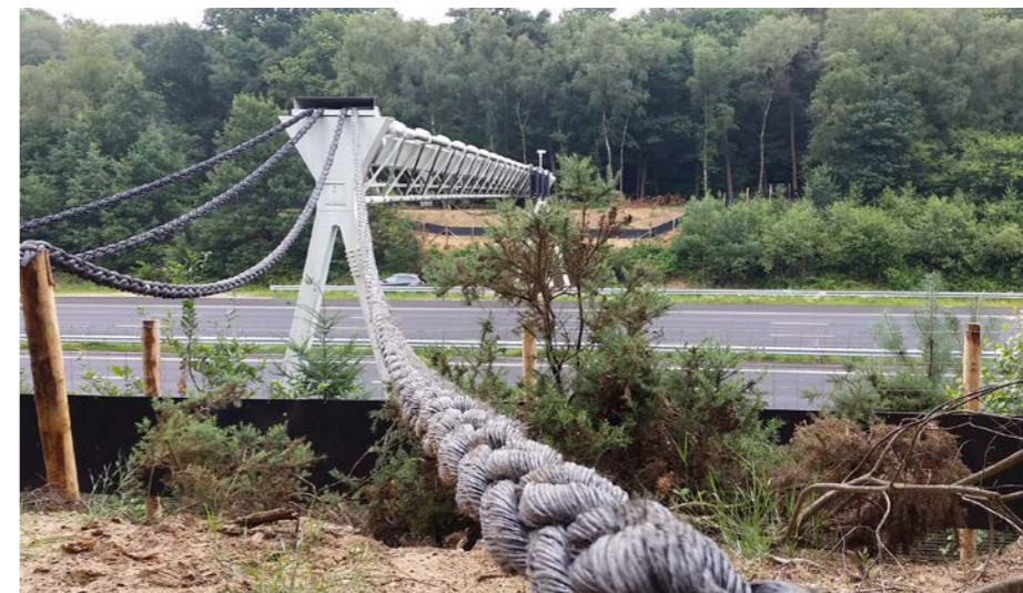
Wegportalen boven de A12 Veenendaal, Ede, Grijsoord zijn geïntegreerd met loopgoten voor marters en eekhoorns. Niet vergeefs, wijst monitoring uit. De dieren maken er gebruik van.
