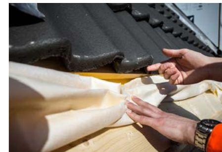
In de gerenoveerde dakgoten is rekening gehouden met de oorspronkelijke bewoners: de mussen.
