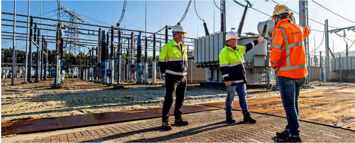
Ingo Seuren van Heijmans, Douwe Zijlstra en bouwleider Hans Greven van TenneT op het hoogspanningsstation in Meeden.
