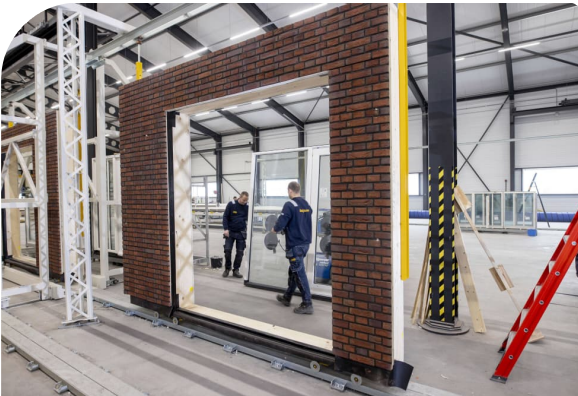
Horizon-elementen uit de houtskeletbouwwoning- fabriek in Heerenveen
