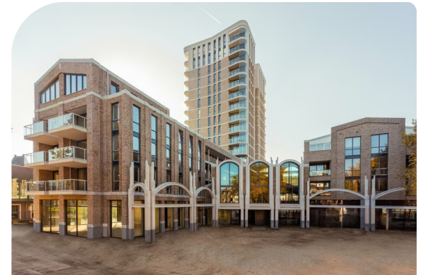
Realisatie project Walkwartier Oss
