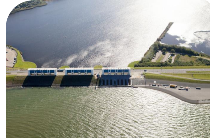
Dike reinforcement Lauwersmeerdijk
