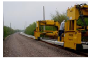
Heitkamp Rail: aanleg 7,5 km. Hogesnelheidslijn. traject
